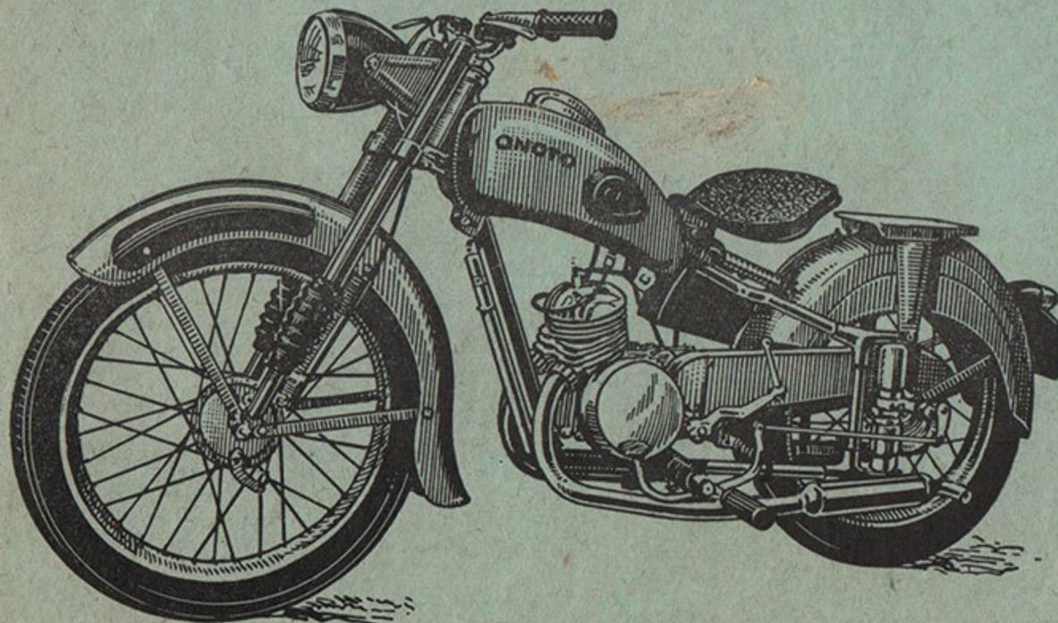
Bloc-moteur 125 cm<sup>3</sup> " YDRAL " quatre vitesses; sélecteur au pied; fourche télescopique; suspension arrière.
