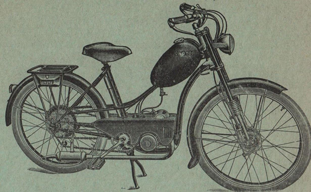
Bloc-moteur " V.L.T. " deux vitesses; réservoir 6 litres; selle suspendue; fourche télescopique; deux freins tambour grand diamètre.
