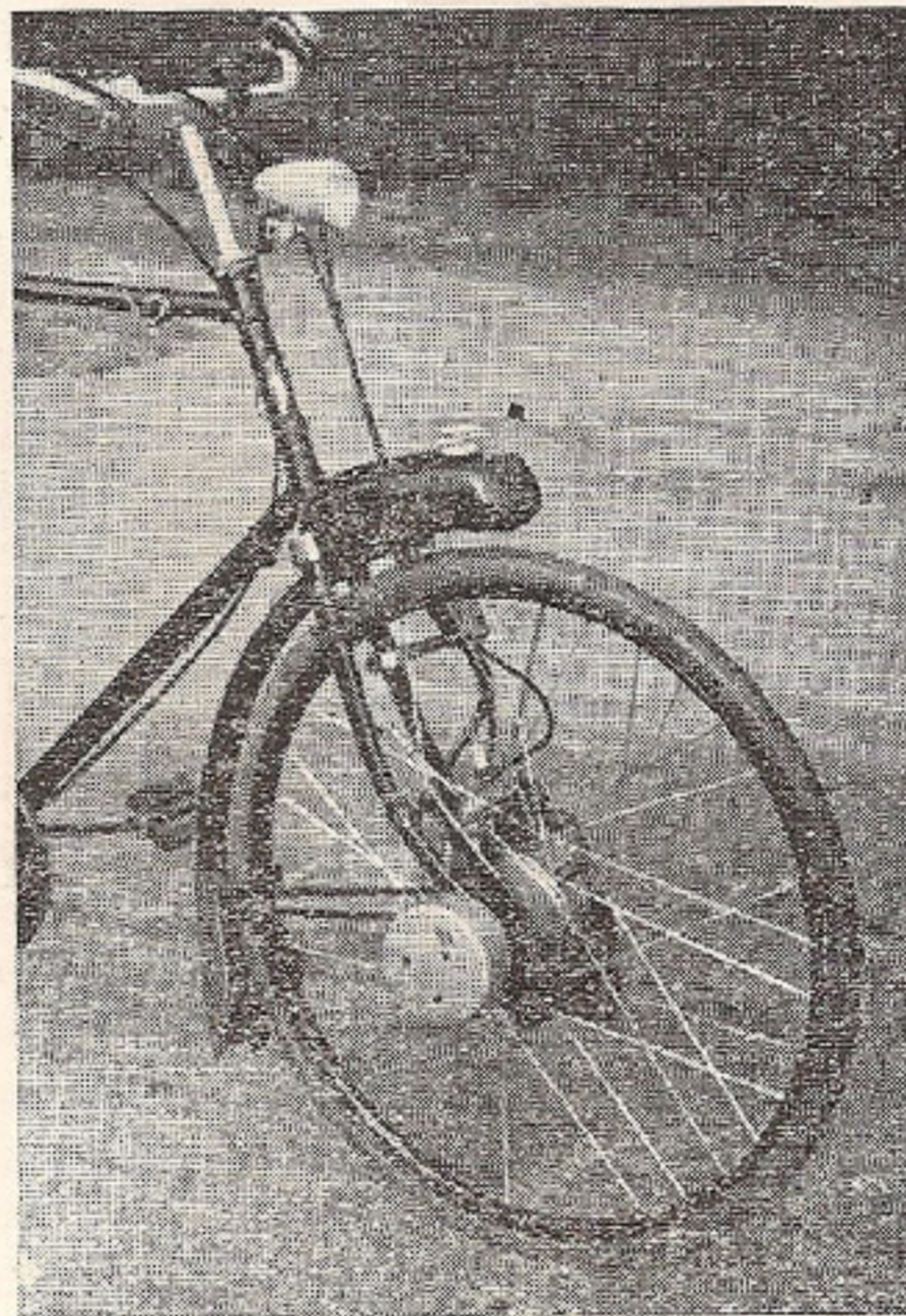
LE MOTEUR MECHANICA, COTE VOLANT MAGNETIQUE.
