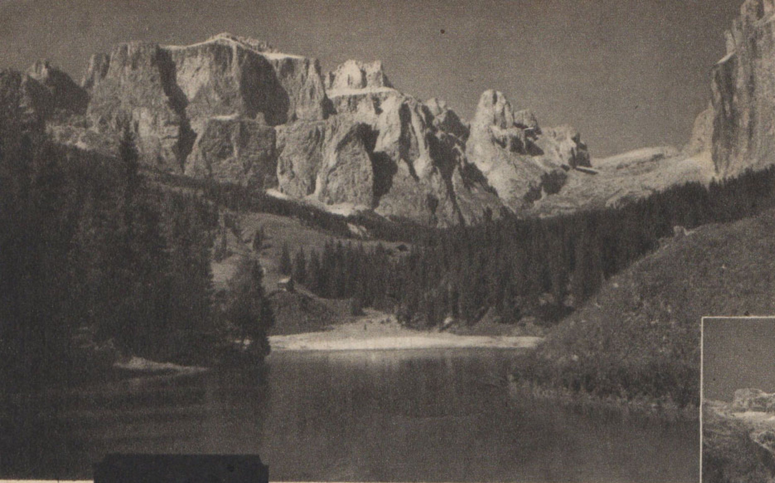
DOLOMITES : Lac de barrage.
