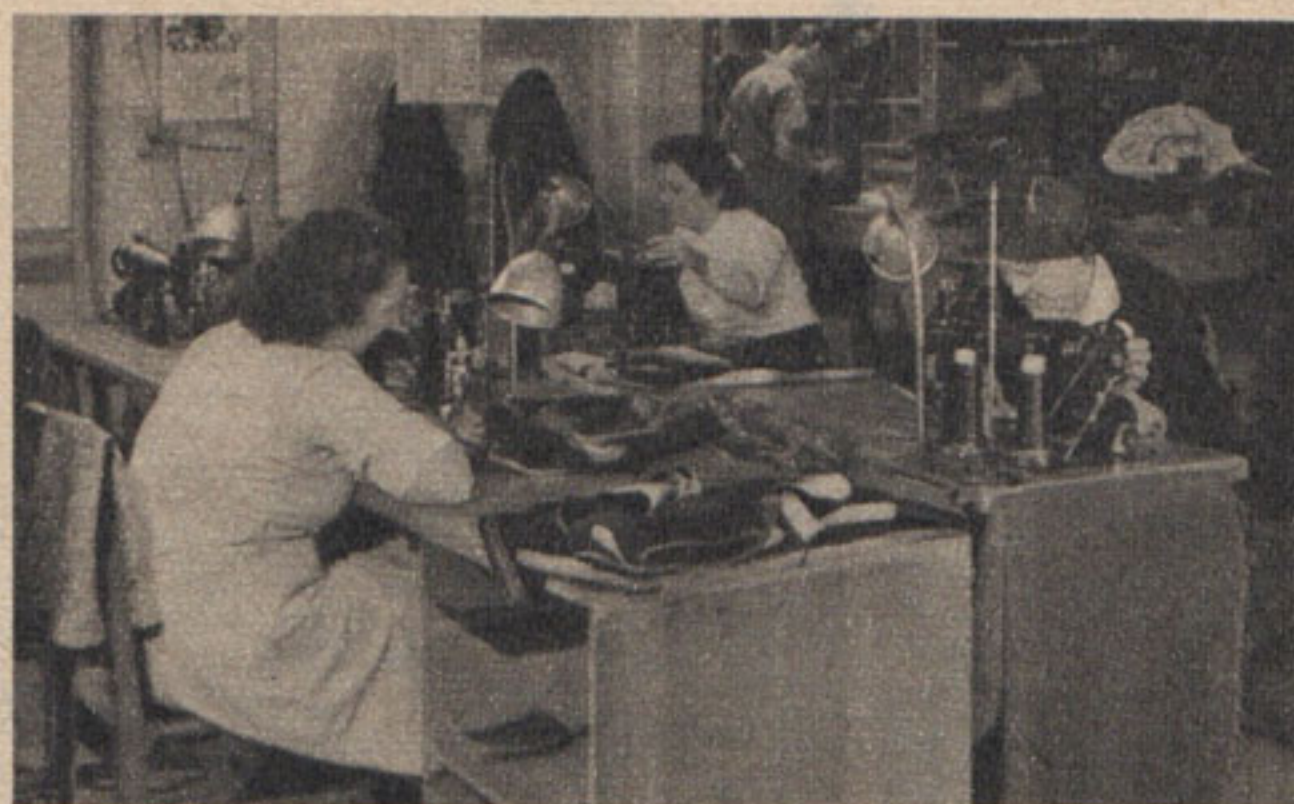
Usinage des armatures des selles.
