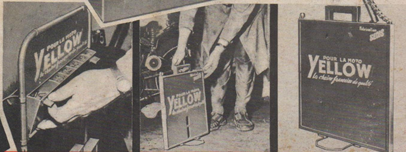
Le support des distributeurs permet le classement méthodique des pièces détachées. Le dérive-chaîne est toujours à portée de la main.
