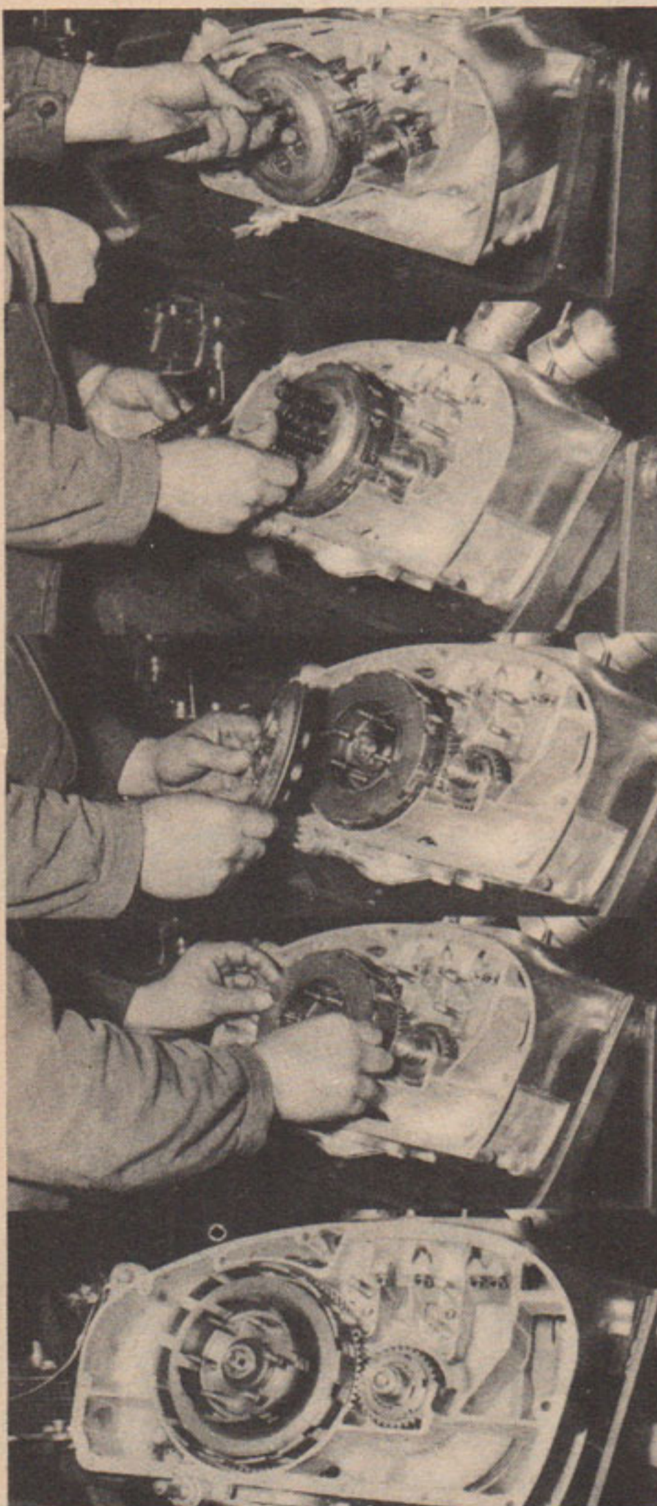
DÉMONTAGE DE L'EMBRAYAGE. DÉTAIL DU VOLANT.
