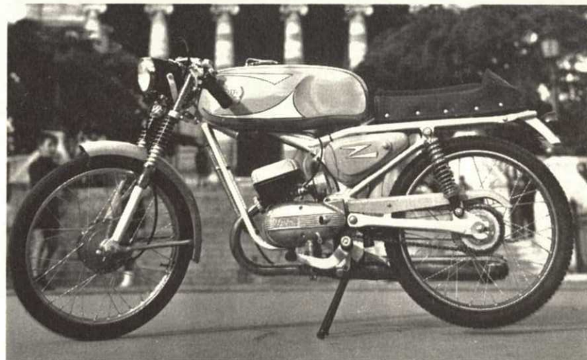
« DOUBLE BERCEAU » ET AILETTAGE DES CARTERS
