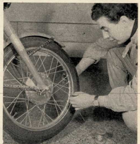
Equilibrage des roues au moyen de fil de plomb enroulé autour des rayons.
