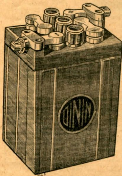
Ci-dessus un accumulateur Dinin à trois éléments pour automobile. Le croquis ci-contre montre un autre accumulateur possédant aussi trois éléments (accumulateur CAV.)
