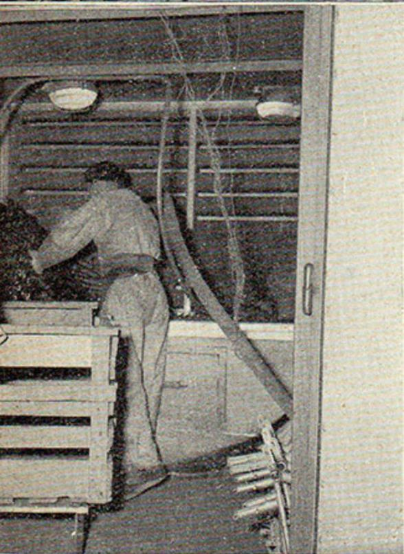
◀ Le système de sablage tel qu'il était utilisé jusqu'au 15 septembre. Dans le fond de la chambre spéciale coule, le long de la paroi, une nappe d'eau. Les ouvriers portent un « scaphandre » protecteur. ▶
