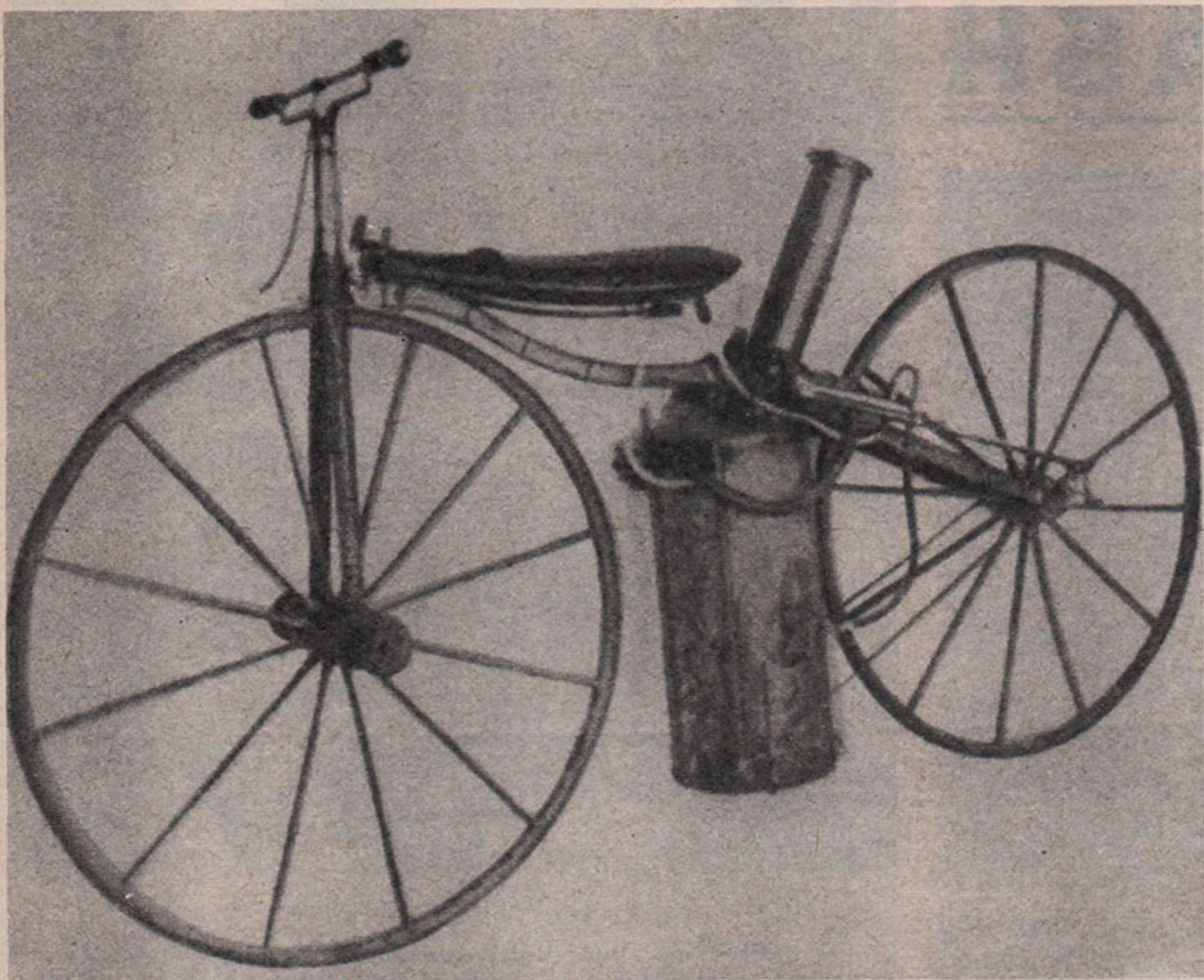
Le vélocipède Hanlon auquel l'américain Roper appliqua son moteur à vapeur. Il a été construit entre les années 1860 et 1869.
