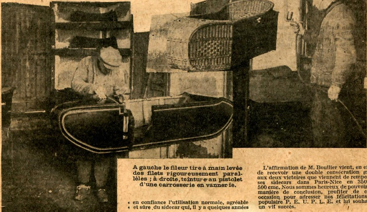
A gauche le fileur tire à main levée des filets rigoureusement parallèles ; à droite, teinture au pistolet d'une carrosserie en vannerie.
