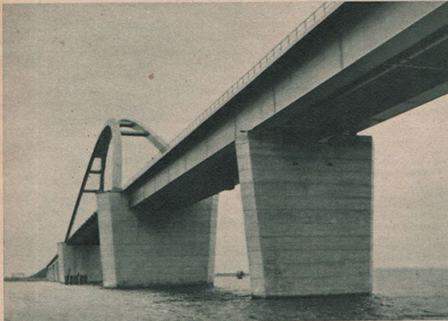
Nebenstehend: Die neue Fehmarn-Brücke, Sinnbild und ausschlaggebende Voraussetzung für die Vogelfluglinie.
