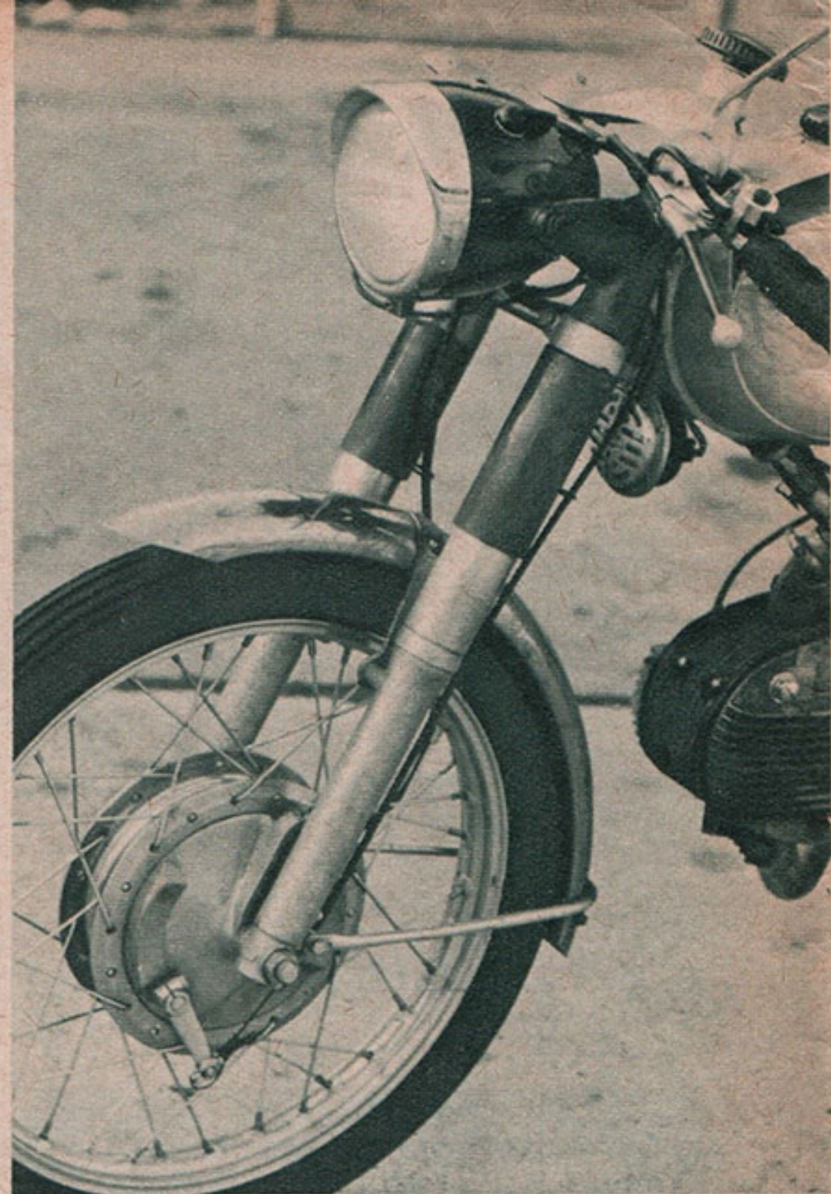
Diese Telegabel und diese Bremsen werden seit mehr als acht Jahren in die im Grundprinzip stets gleichen Motobi-Modelle eingebaut. (Fotos Klacks)
