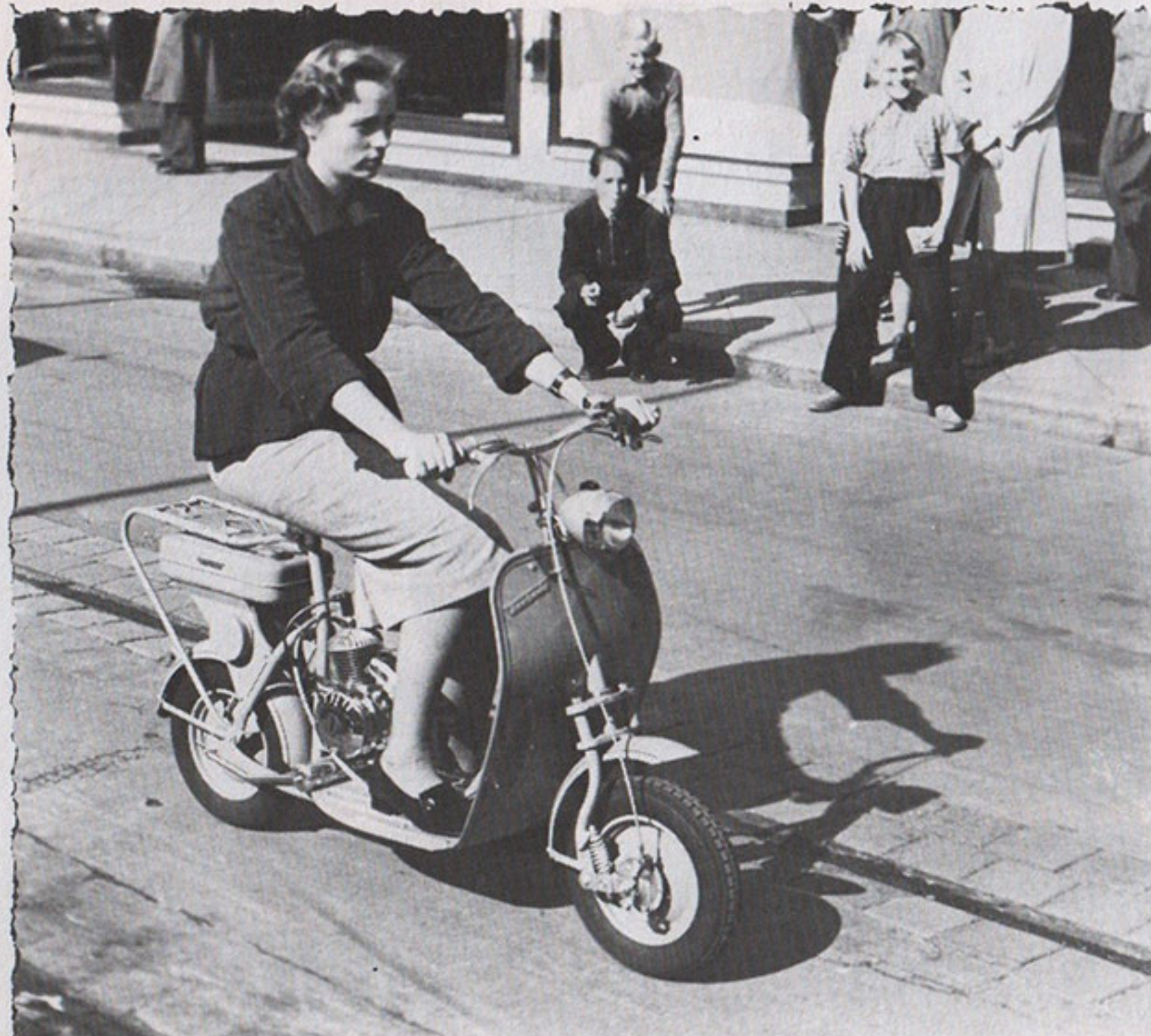
Foto oben: Um sich für die Straßenbahnfahrer-Prüfung zu qualifizieren, lernte Steffi Steffanowski das gesamte Gleisnetz auswendig. Dabei stellte sie mit ihrem Roller-Saurier den Rundstreckenrekord in der Wilhelmshavener Fußgängerzone auf und bewies, daß der ÖPNV nicht der Weisheit letzter Schluß ist
