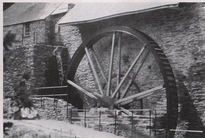
Dieses Wasserrad am kleinen Dyfi-Fluß treibt keine Mühle, sondern wurde seit 1755 benutzt, um zwei Blasbälge für einen Hochofen in Bewegung zu setzen
