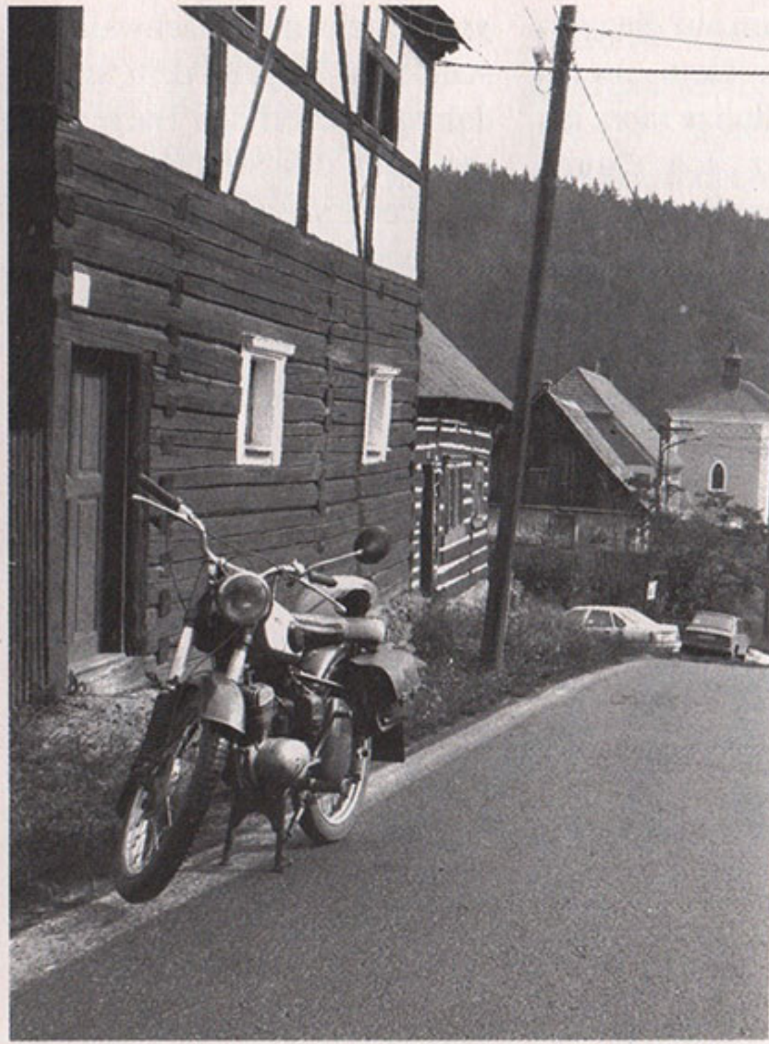
Rabštejn - zwei Restaurierungsobjekte
